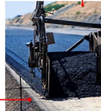
Thi công mặt đường
